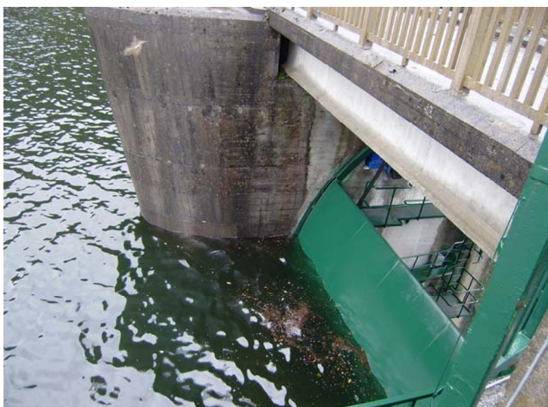
Compuertas "Taintor" del aliviadero cerradas y reteniendo mayores volúmenes en el embalse
