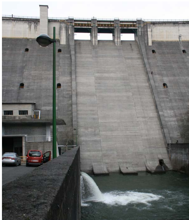
La presa de Añarbe con las compuertas del aliviadero abiertas y vertiendo al río Añarbe únicamente el caudal ecológico
