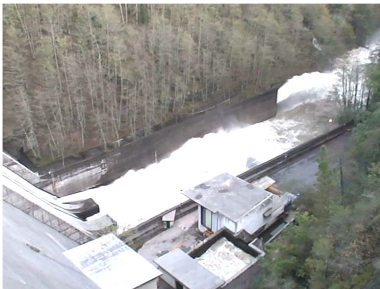
Apertura del desagüe de fondo izquierdo el martes 8 de noviembre
